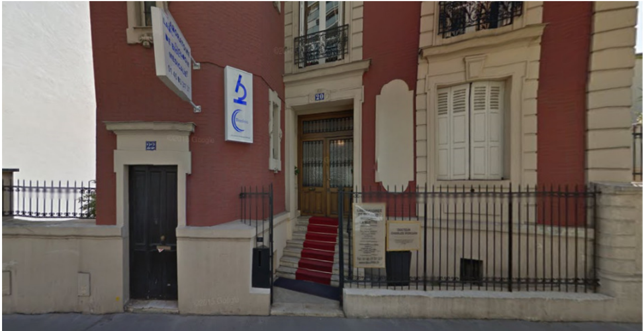
Rue de la Pompe, Paris
